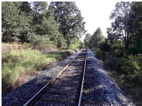
Obr. 1 Pohled po směru staničení
