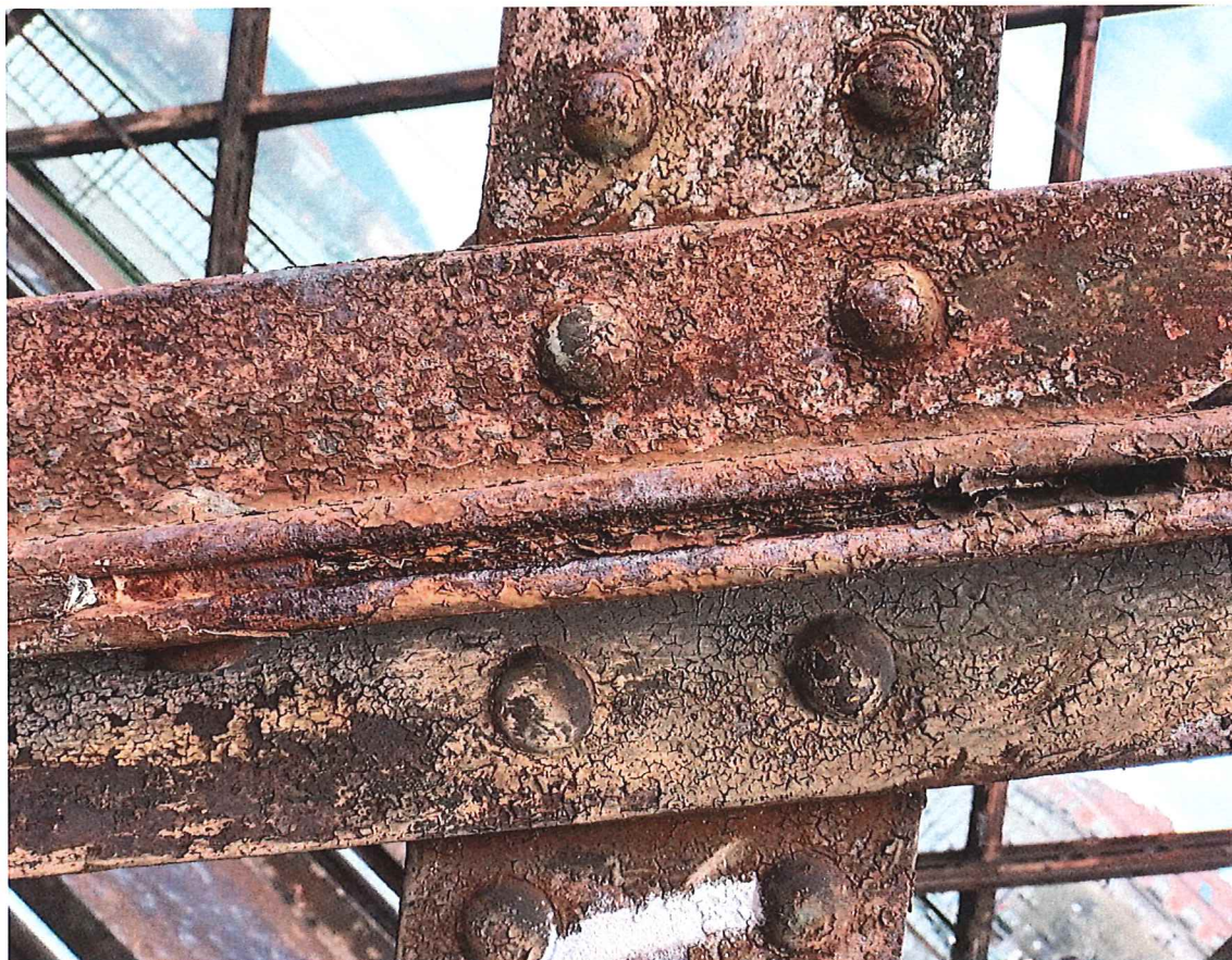
Typický příklad vyplnění úzké mezery korozními produkty (v četných případech dochází k dalšímu rozpínání s deformací přírub, hrozí stříhání nýtů)
