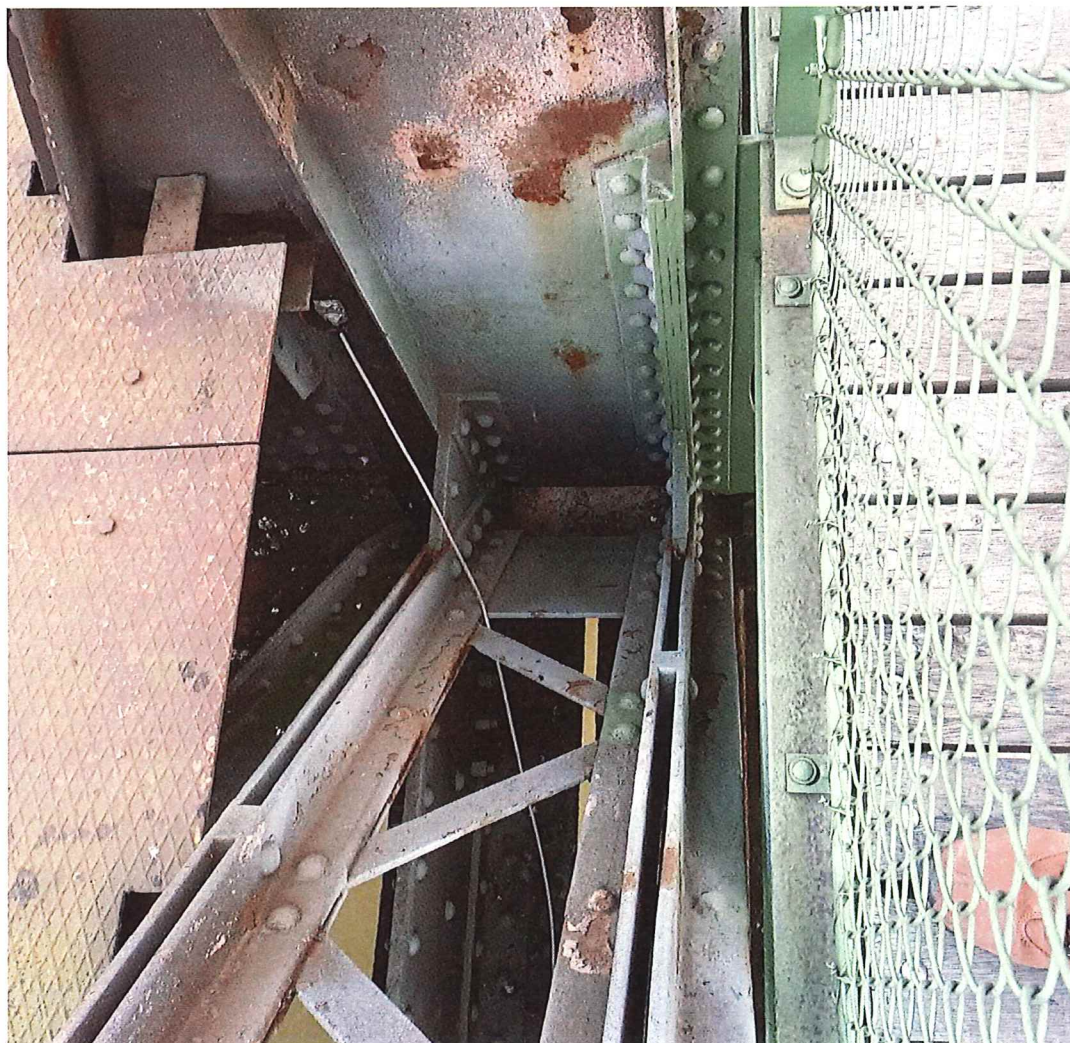
Měřicí čidlo monitoringu osazené na konstrukci
