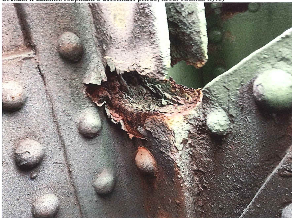
Typický příklad prokorodování přírub prvků hlavního nosníku v korozně nevhodně navržených detailech
