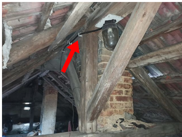
foto/18/ Pohled na vedení rozvodů po konstrukci krovu
