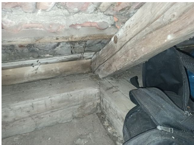
foto/17/ Pohled na osedlání krokve na okapovou vaznici
