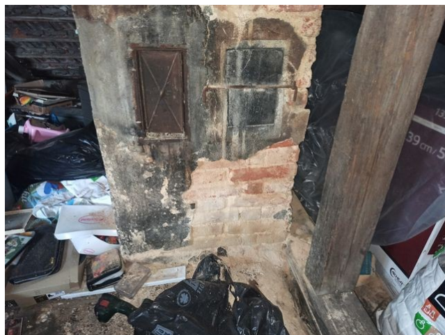
foto/14/ Pohled na konstrukci komína se silně zdegradovanou povrchovou úpravou
