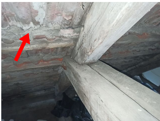
foto/15/ Pohled na utěsnění krytiny pomocí cementové malty
