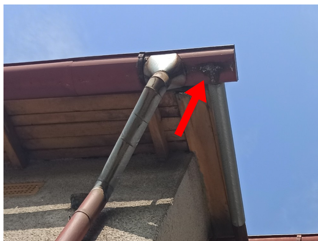
foto/28/ Pohled na netěsné provedení stávajícího podokapního žlabu
