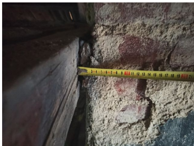
foto/16/ Pohled na vzdálenost komínového tělesa od dřevěného prvku krovu
