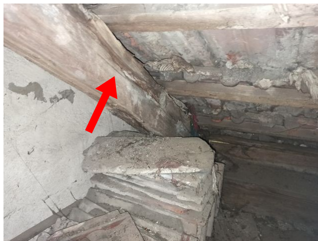
foto/20/ Pohled na poškozený (prasklý) krov v místě obvodové stěny
