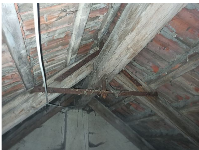
foto/23/ Pohled na osazený kovový držák procházející skrze vrcholovou vaznici
