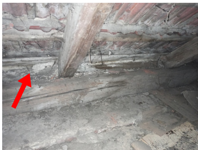
foto/24/ Pohled na uzavření mezery v místě okapové vaznice pomocí malty
