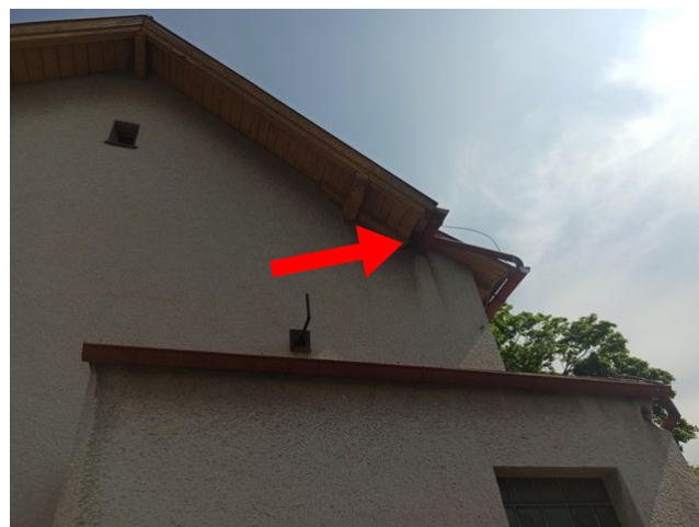
foto/12/ Pohled na zdegradovaný okap, známky přetékání okapu na fasádu
