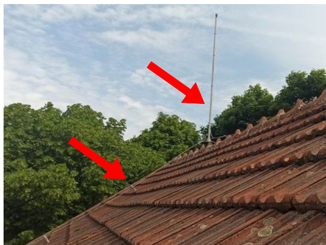
foto/32/ Pohled na uchycení vodiče v ploše střechy a jímací tyč
