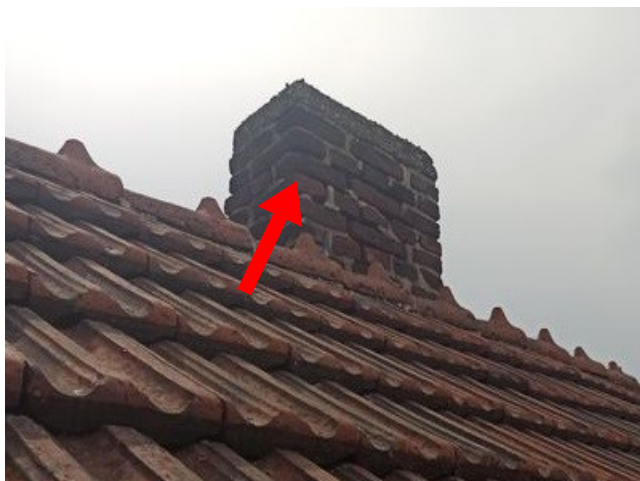
foto/29/ Pohled na zvětralé zdivo komínového tělesa
