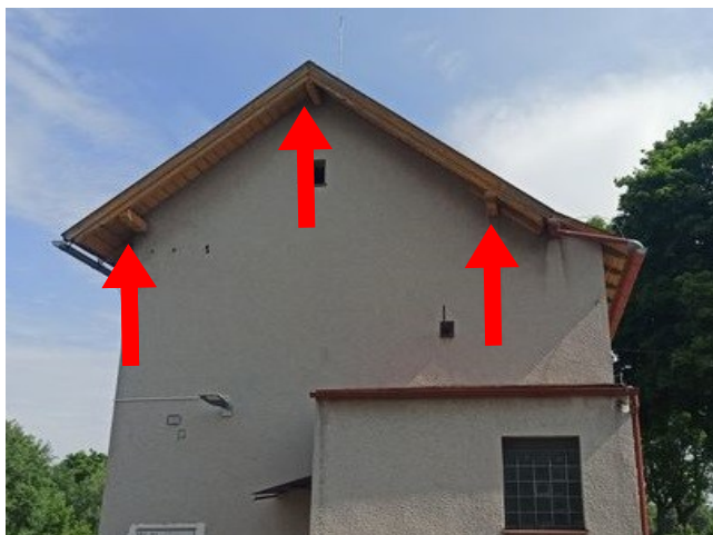
foto/9/ Pohled na vystupující prvky krovu z obvodové stěny
