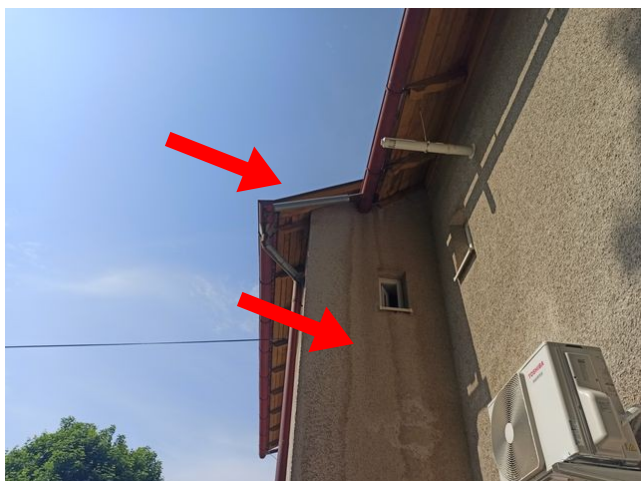
foto/11/ Pohled na řešení odvodnění střešního pláště, známky zatékání srážek po fasádě
