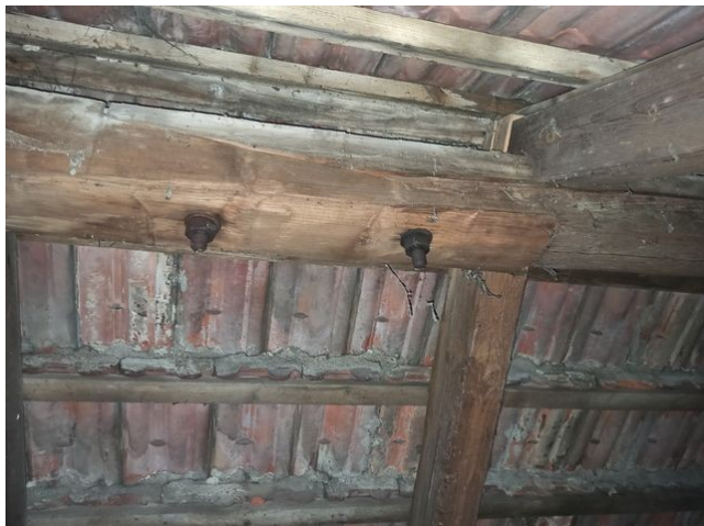
foto/25/ Pohled na spojení vrcholové vaznice pomocí šikmého plátu a dvojice ocelových svorníků
