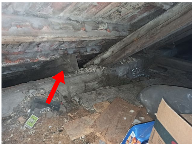
foto/21/ Pohled na osazenou krokev na okapové vaznici (část střechy bez přístupu)
