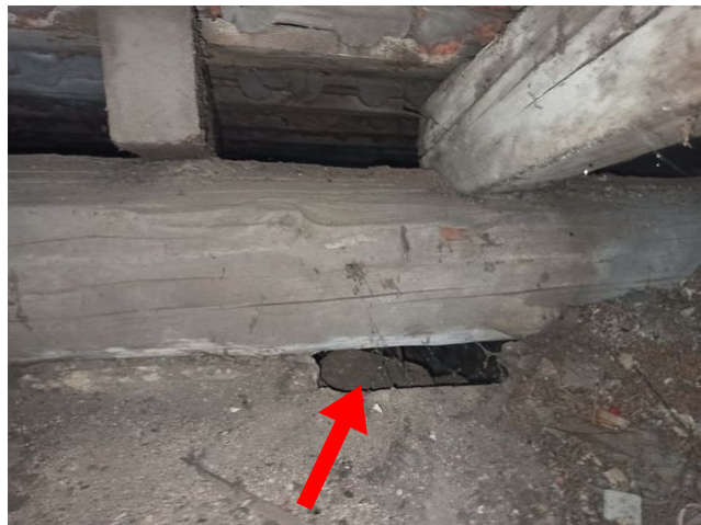
foto/26/ Pohled na uvolněnou část podlahy pod okapovou vaznicí
