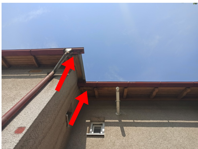
foto/27/ Pohled na poškozené bednění v místě okapu hnilobu po předešlých zátocích v místě okapu
