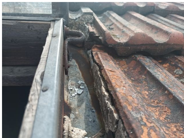
foto/30/ Pohled na boční oprácorování střešního výlezu na střeche s drolící se maltou
