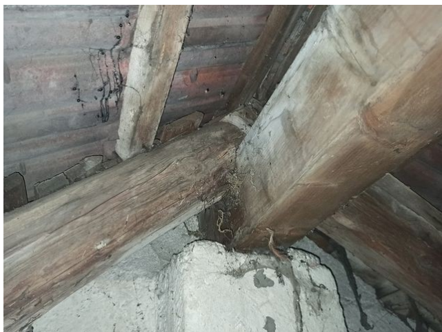
foto/19/ Pohled na osazenou vrcholovou vaznici na zděném sloupku
