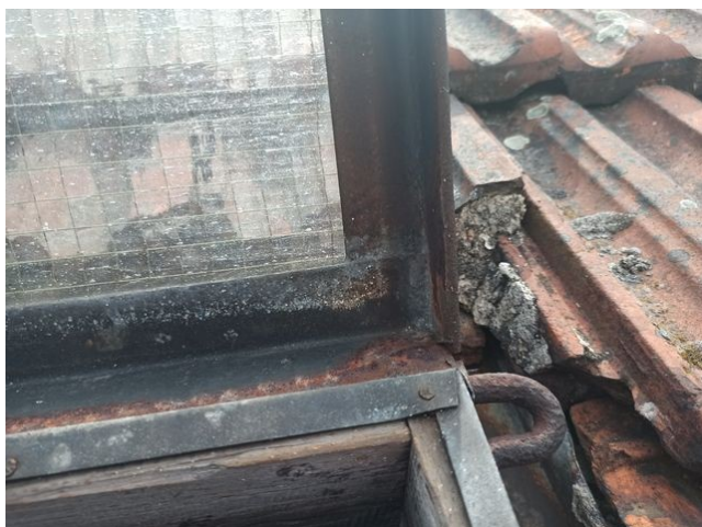
foto/31/ Pohled na zkorodovaný výlěz s drátosklem
