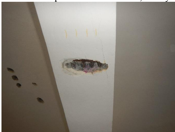
Foto č. 1–3 – pohled na sondu NV 1, detaily výztuží
