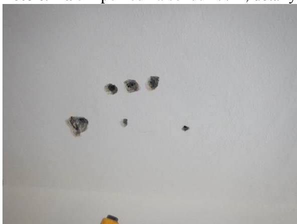
Foto č. 4 a 5 – pohled na sondu NV 2, detaily výztuží
