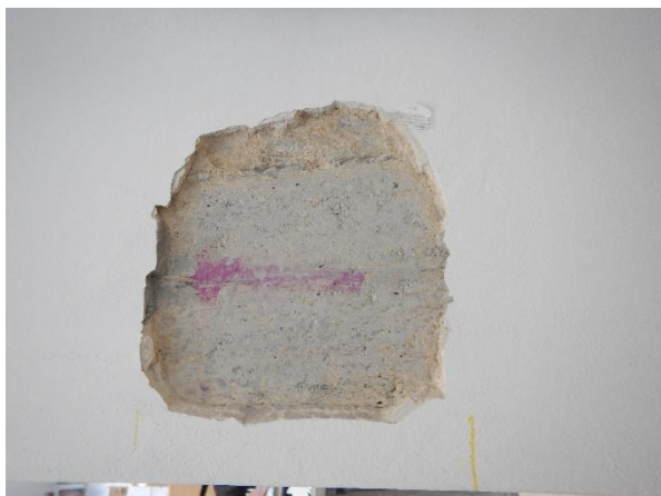
Foto č. 4 a 5 – pohled na sondu NV 2, detaily výztuží
