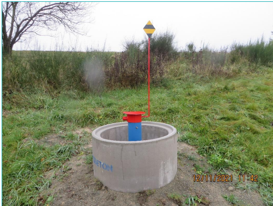
Obrázek 8 Požadovaná ochrana zhlaví vystrojeného vrtu
